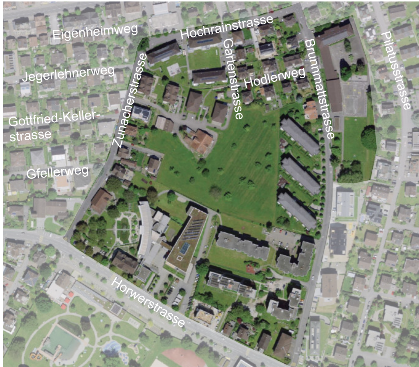
Luftbild Zunacherstrasse / Brunnmattstrasse (Quelle: swisstopo)
